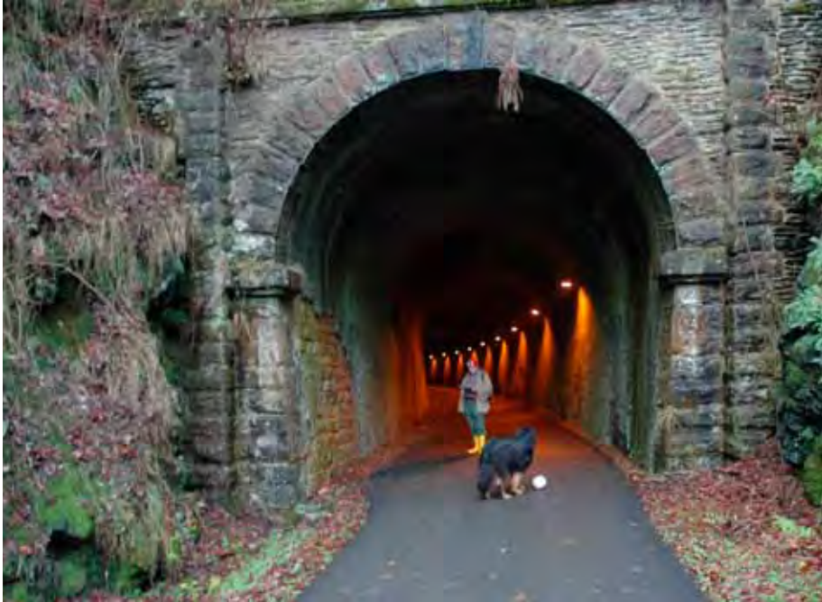
Abb. 13: Tussen-Tunnel I. Foto: Harbusch.
