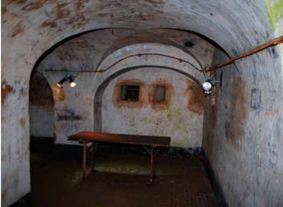
Abb. 60: Fort Berlaimont wurde im zweiten Weltkrieg ausgebaut. Foto: Steiner.
