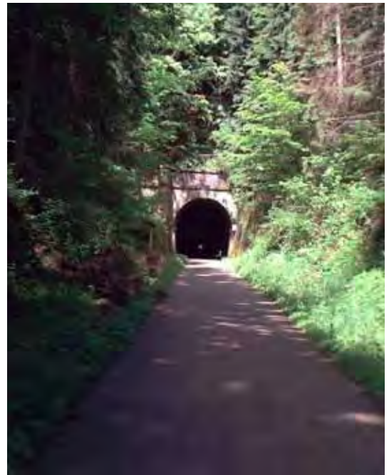
Abb. 42: Tunnel vun Habscht. Im Hintergrund der zweite Ausgang.
