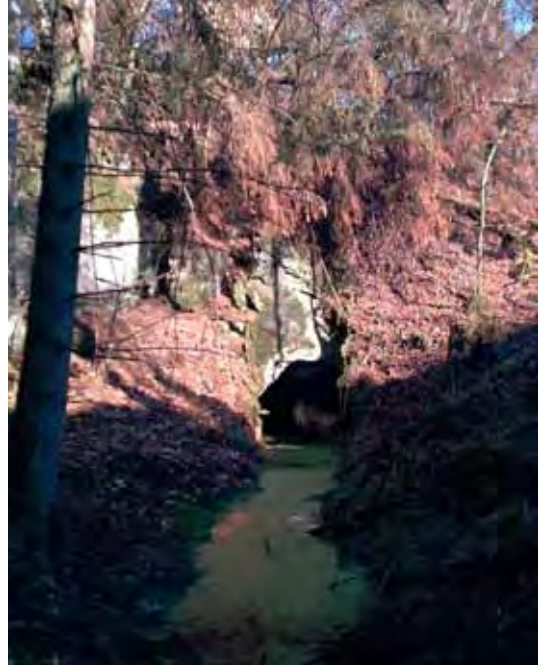
Abb. 12: Grouwentunnel mit durchfließendem Bach.
