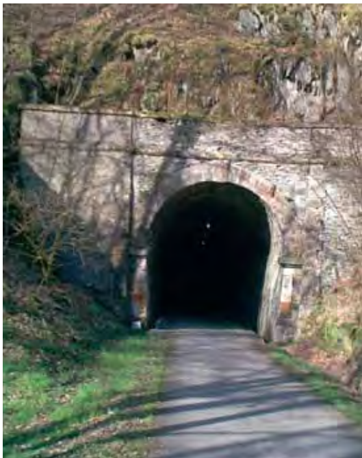
Abb. 17: Hälzchen-Tunnel. Man erkennt die elektrische Beleuchtung.
