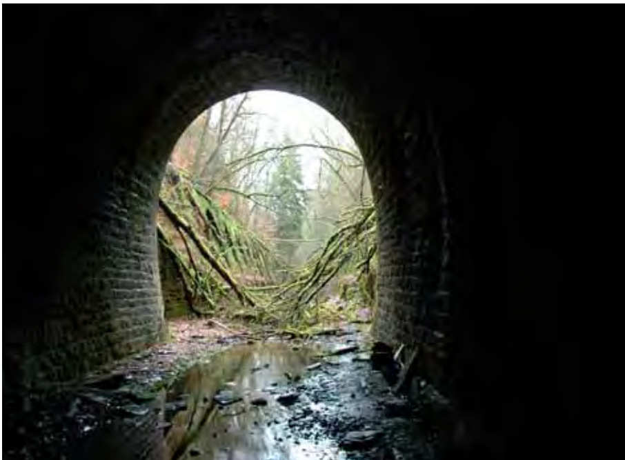
Abb. 6: Tunnel Huldange. Foto: Harbusch.
