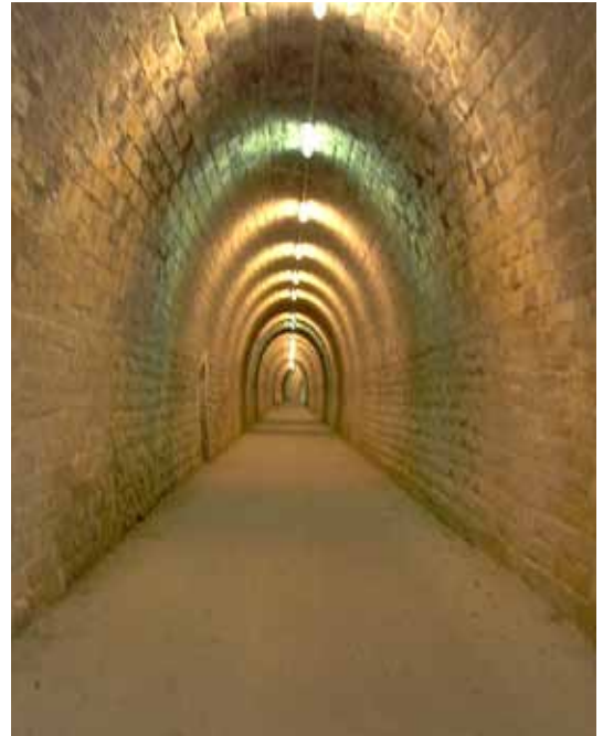
Abb. 51: Der Grassebiergtunnel ist ausgebaut und beleuchtet.
