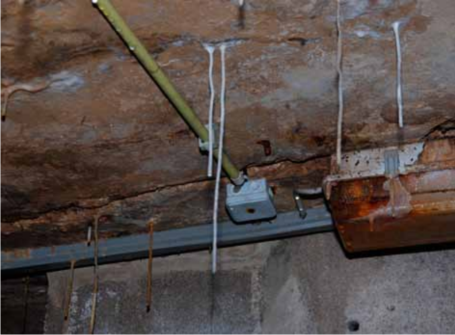
Abb. 59: Fort Louvigny ist mit elektrischer Beleuchtung ausgestattet, zwischen der Sinter- röhrchen wachsen. Foto: Steiner.
